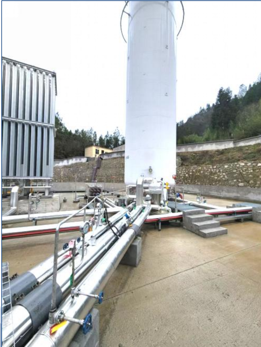
LNG 플랜트 충전
