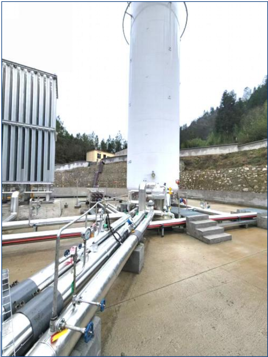
LNG 플랜트 충전
