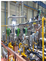
한국기계연구원 천안 LNG 50A(2), 65A(2), 80A, 100A, 125A, 150A ~ BEA FN질량유량계
