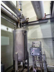
㈜홍보에너지 군산공장 부위설비 바이오가스 정 제설비 공급거래용, 125A 라인 FN질량유량계
