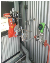
이천(잔존사체처리시스템) LPG, 25A 라인 FN질량유량계
